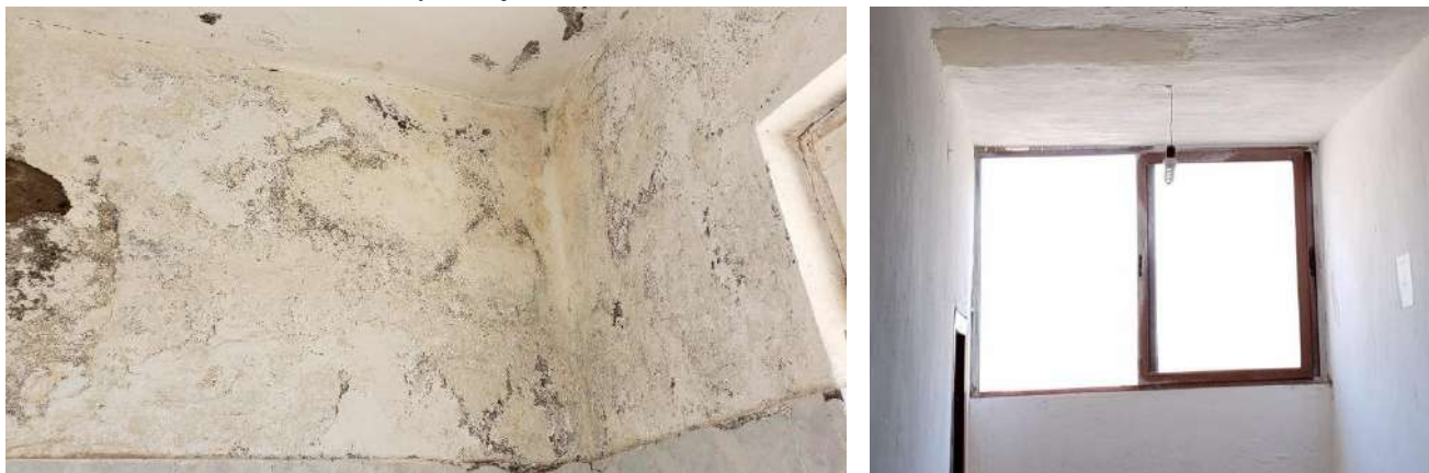
Figura 15-16. Foto të problemeve me lagështinë dhe mungesën e izolimit
