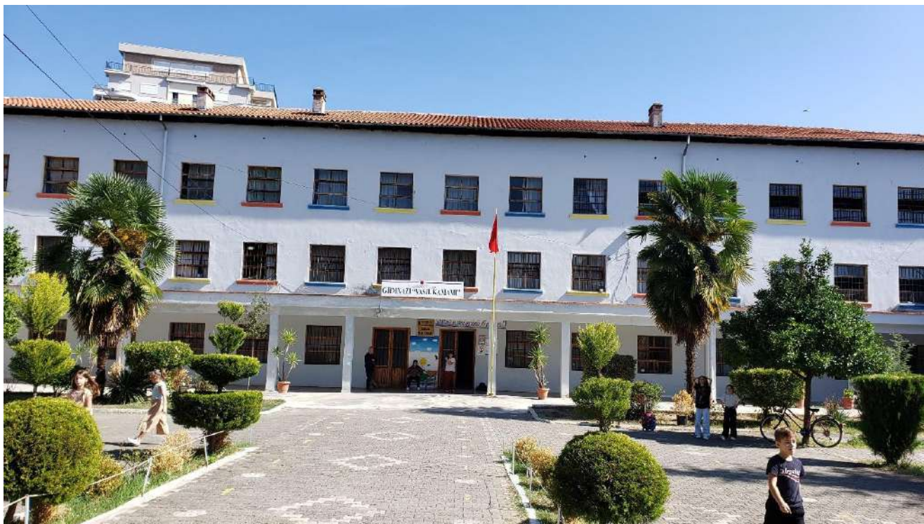
Figura 1. Foto e fasadës kryesore të shkollës
