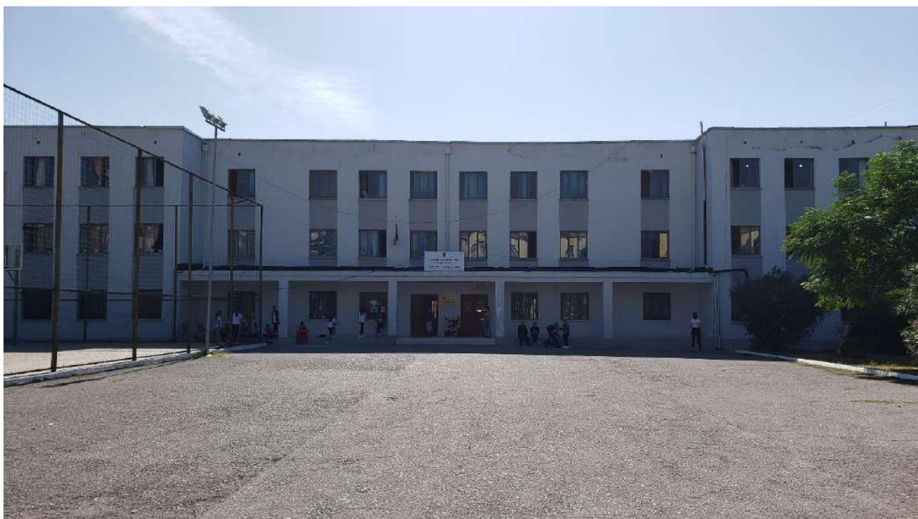
Figura 1. Foto e fasadës kryesore të shkollës
