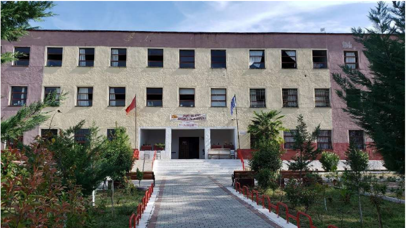
Figura 1. Foto e fasadës kryesore të shkollës
