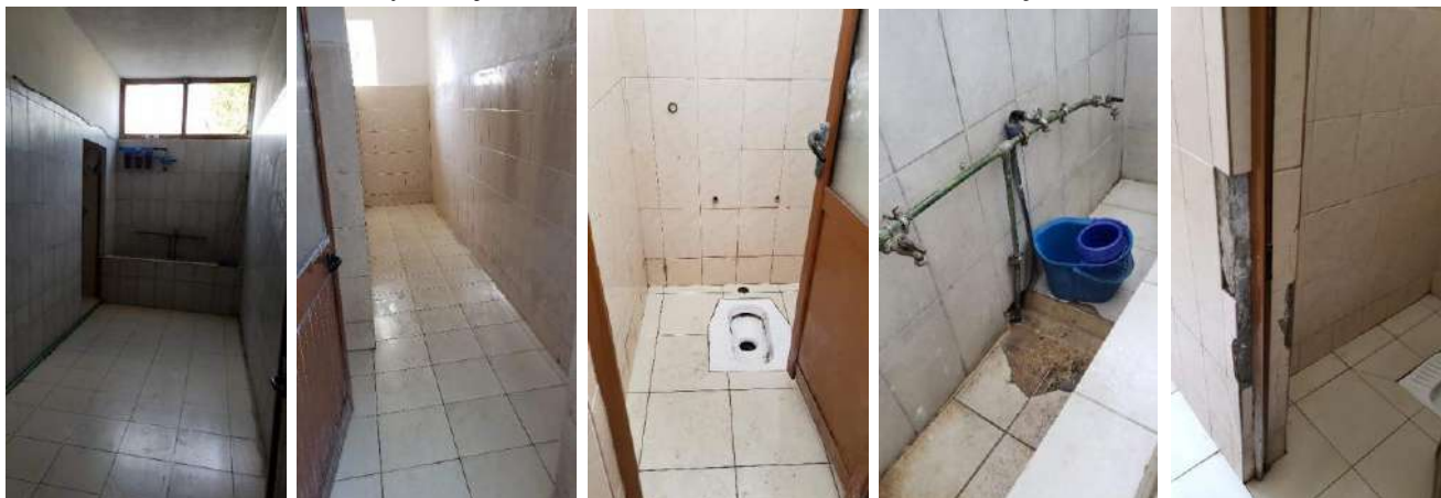
Figura 21-25. Foto të tualeteve të shkollës
